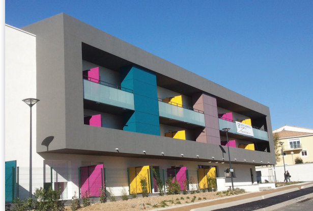
Résidence Accueil "La Bastide" à Grabels
